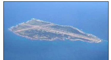
馬毛島における施設整備
