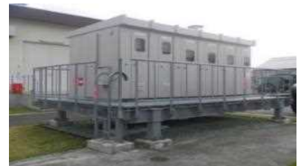
受変電設備の高所化（津波対策）
