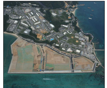
普天間飛行場代替施設の建設
