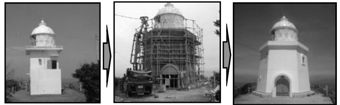
補強前 耐震補強 補強後
