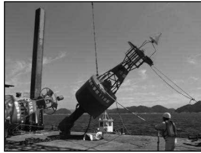
灯浮標の設置
